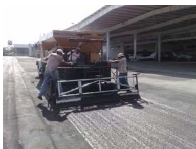
Rehabilitación Calle P con Slurry Seal
