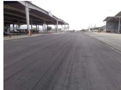
Rehabilitación Calle P con Slurry Seal
