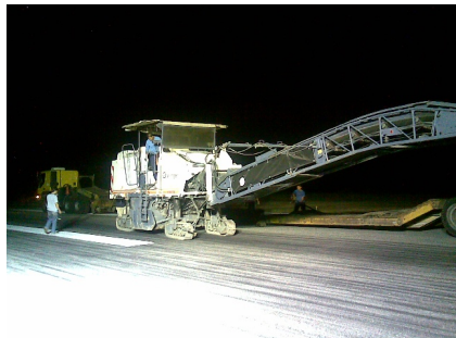
Reparación de la pista.
