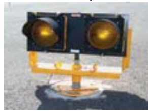
Luz de protección de pista elevada
