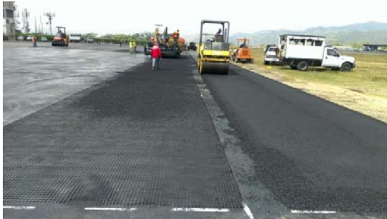
Geomalla antes de ser recubierta con asfalto
