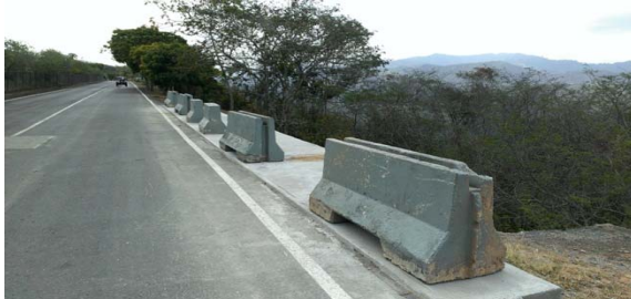
Vista desde la Vía Perimetral Norte
