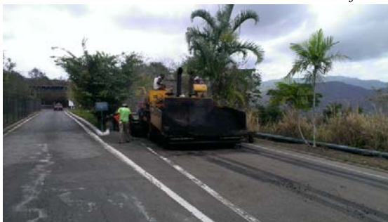
Bacheo en Vía Perimetral Norte
