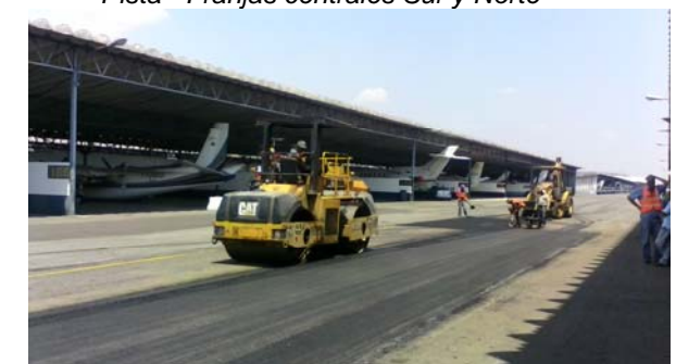
Reparación de baches en Calle de Rodaje
