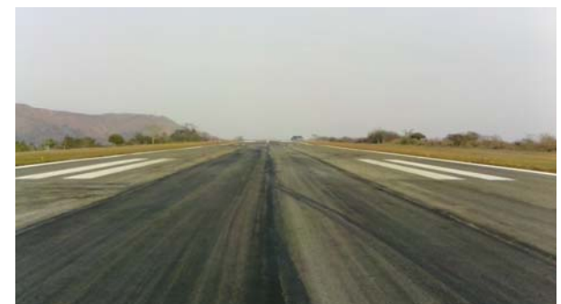
Pista - Franjas centrales Sur y Norte
