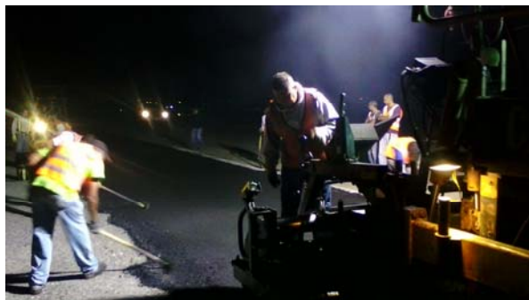
Trabajos nocturnos en la pista
