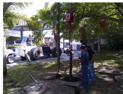
Extracción de bombas
