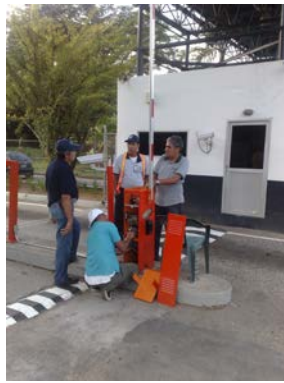
Reparación de Barreras
