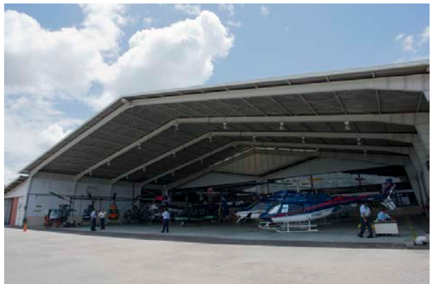
Hangar de Aerotécnica en el Aeropuerto Caracas
