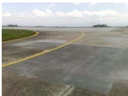
Nivelado y microcarpeta de recubrimiento
