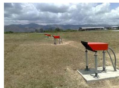
El personal técnico del Departamento de Electricidad y Telecomunicaciones del aeropuerto, con el apoyo del Departamento de Obras Civiles, completó exitosamente la instalación y las pruebas funcionales del PAPI (Precision Approach Path Indicator). Este equipo contribuye efectivamente a elevar la seguridad en las operaciones de aterrizaje.
