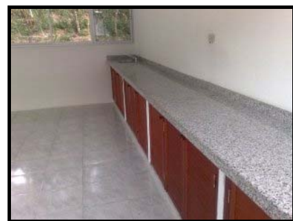
Mesón multiuso en granito
