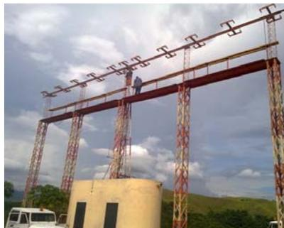
Se cambió la madera de las barandas en la pasarela elevada, continuando con el mantenimiento de las antenas radiantes y la pintura de la estructura metálica.
